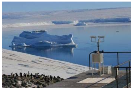
© LGGE Installation permettant la collecte des particules de l'air
